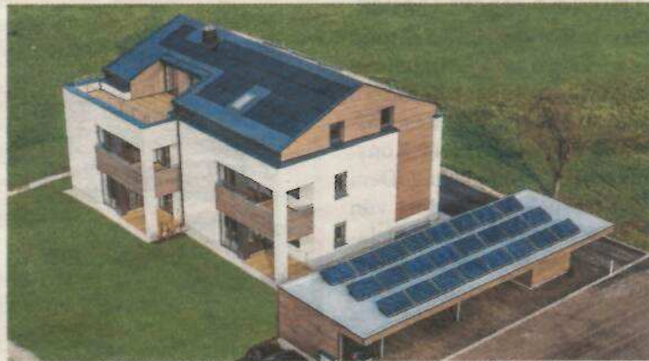
Das „Haus der Zukunft 2020“ vereint innovative Energie-Lösungen. Foto: arch foto 360
